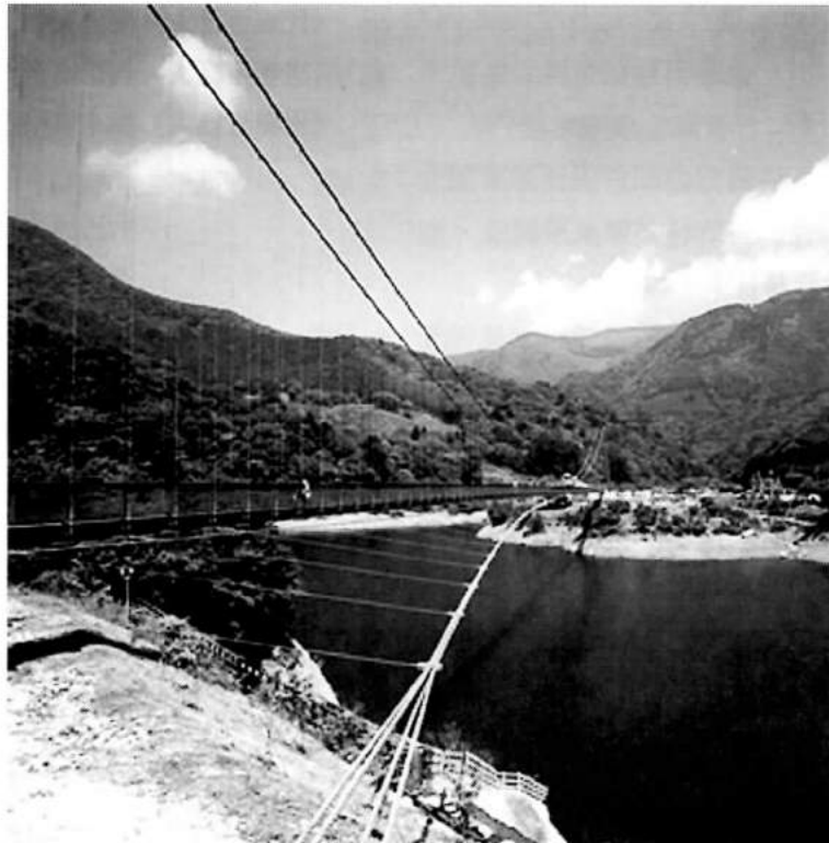
もみじ谷大吊橋
